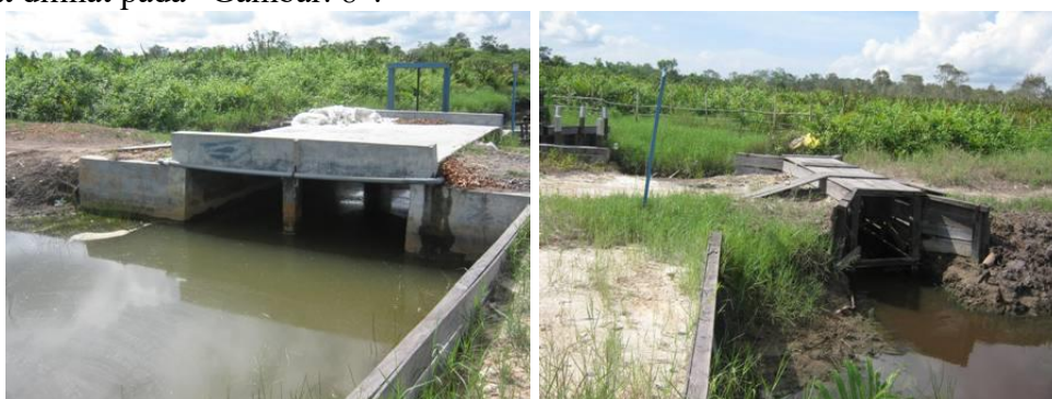
Pintu air dari beton
