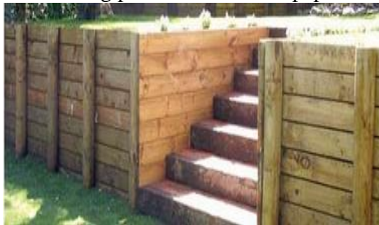
Dinding penahan tanah dari papan
