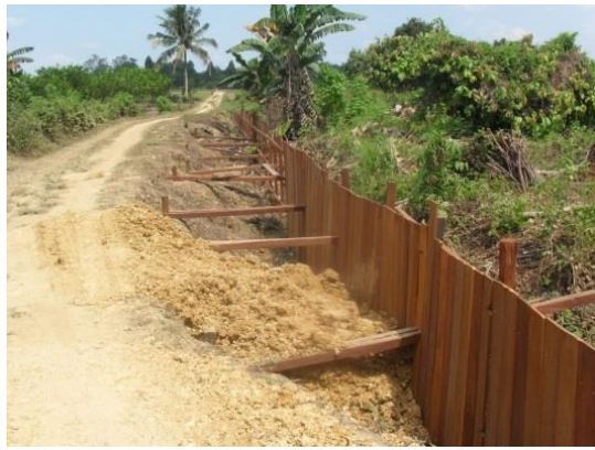
Dinding penahan tanah dari papan
